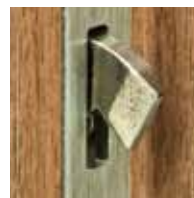
rygiel zamka wielopunktowego listwowego w WERSJI 39 dB
