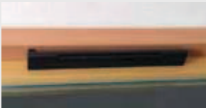
Nawiewniki higrosterowane (umożliwiają automatyczny przepływ powietrza przy zamkniętym oknie)
