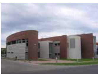
Kompleks basenów, Suchy Las
