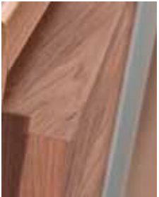
górna krawędź skrzydła w systemie bezprzylgowym
